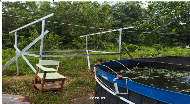
Gambar 3. Proses Pembangunan Instalasi Akuaponik
