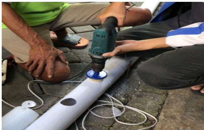
**Gambar 7.** Pembuatan lubang pada pipa paralon
