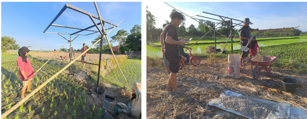
Gambar 7. Pemasangan Stand dudukan panel surya
