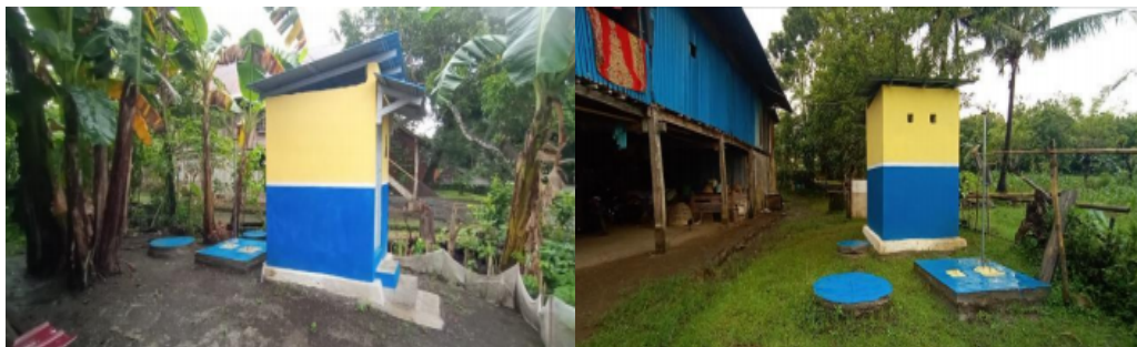
Gambar 6. Toilet yang telah terbangun
