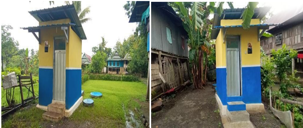
Gambar 3. Toilet individu yang telah terbangun di Kelurahan Bulukunyi
