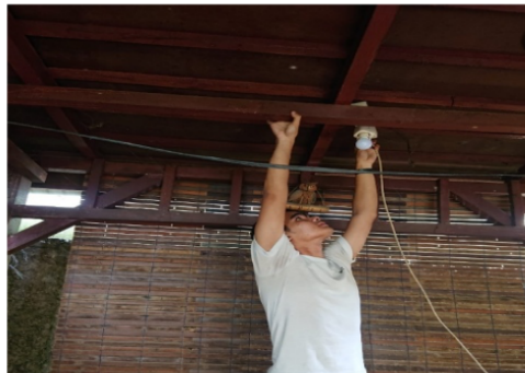
Gambar 1. Pemasangan Smart WiFi Plug
