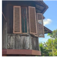
Gambar 3. Jendela Rumah Bari Pesirah Pangkalan Balai
